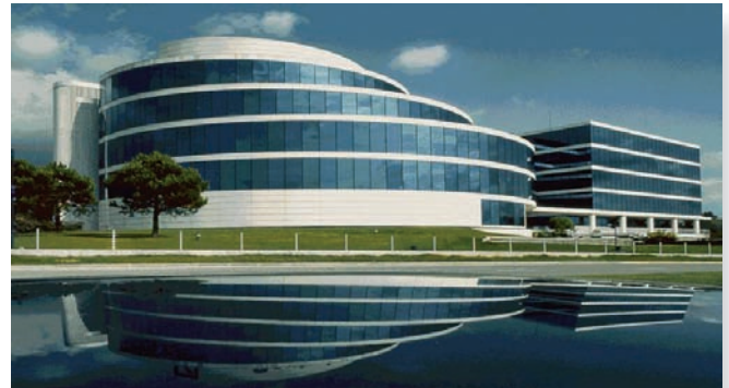
Edificio EDS en Sant Cugat del Vallès
